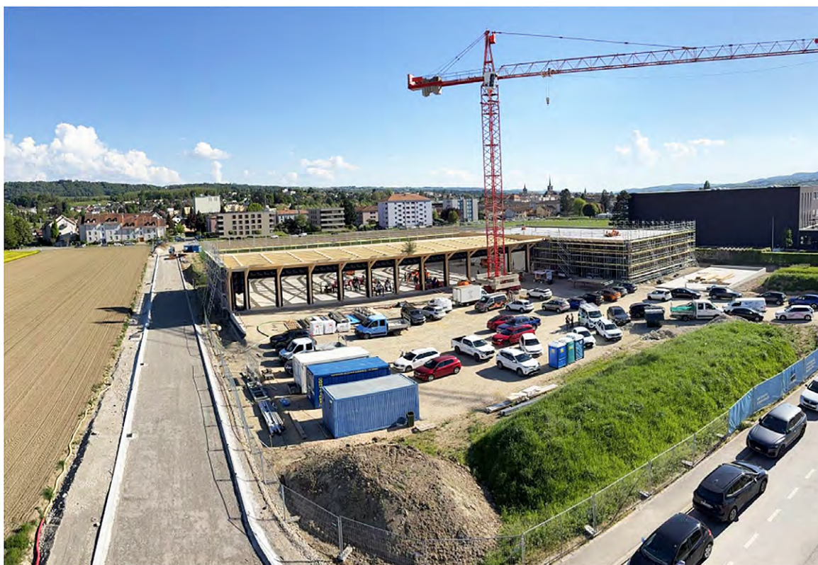
Bouquet de charpente, 1 er mai 2025, fin du gros oeuvre
